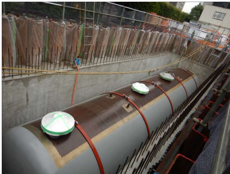
工事中の非常用オイルタンク（2020年6月撮影）
